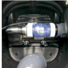
Rückschlagventil RSK und Entleerungspumpe
